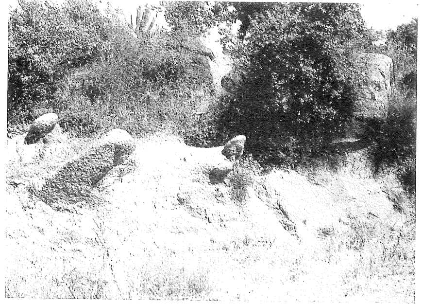
Fot. 1.—Contacto del granito fresco y el alterado, mirando hacia el norte. Km. 18 de la carretera El Pedroso - Castilblanco.
